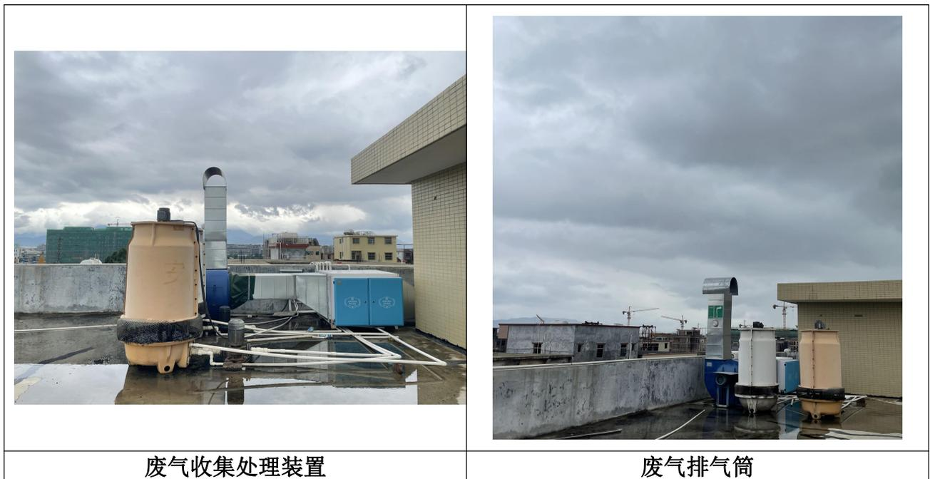
图4-1 废气收集处理装置
