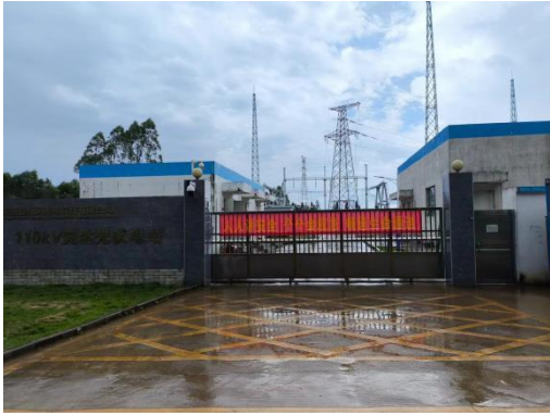
图 6-1 升压站大门外观
